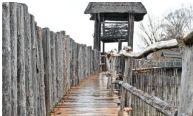
Die hellbraunen Hölzer sind noch ganz frisch, sie stechen aus den durch das Wetter ausgegrauten Hölzern hervor.
