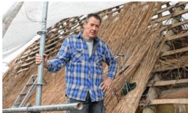
Im März 2025 wird an einem der Dächer gearbeitet. Es muss neu eingedeckt werden. Dafür stehen 2300 Bündel Reet zur Verfügung, die von Volker Barfuß und seinem Team auf etwa 170 Quadratmeter Dach aufgebracht werden. FOTOS: RASMUS PETERS
