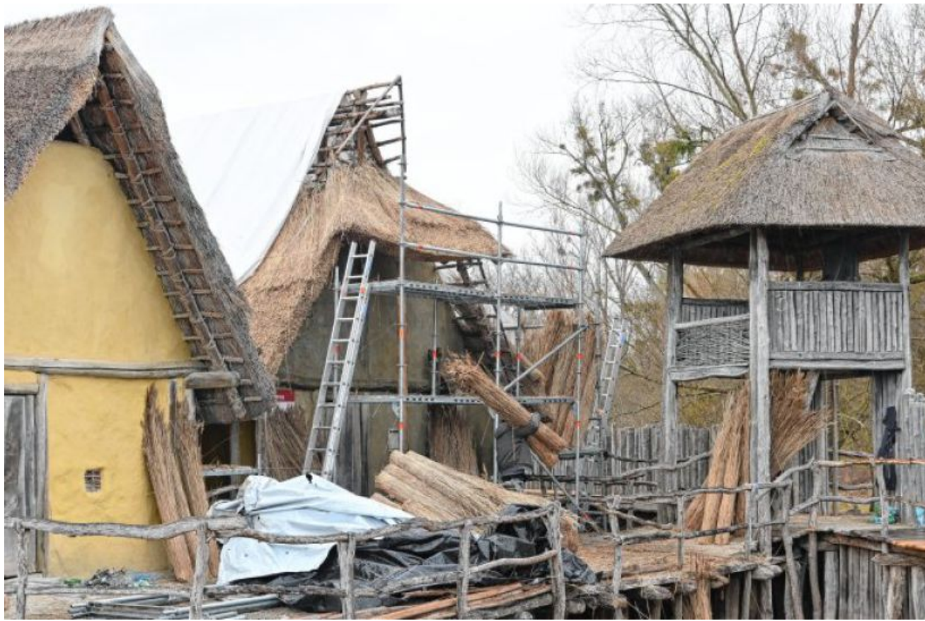
Im März 2025 wird an einem der Dächer gearbeitet. Es muss neu eingedeckt werden. Dafür stehen 2300 Bündel Reet zur Verfügung, die von Volker Barfuß und seinem Team auf etwa 170 Quadratmeter Dach aufgebracht werden. FOTOS: RASMUS PETERS
