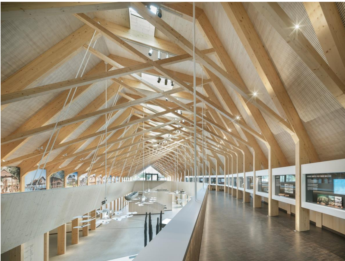
Die Galerie, auf der die Funde präsentiert werden, scheint zu schweben, so luftig ist sie konstruiert. (Foto: Werner Huthmacher)
