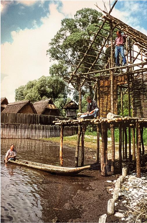
Abb. 2: Der Bau des Hornstaadhauses, ein Experiment, 1996. – Construction of the Hornstaadhaus, an experiment, 1996.
