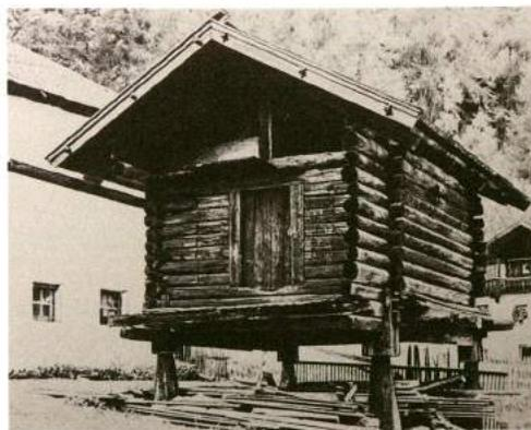
Abb. 8: Ein rezenter Pfostenspeicher aus Lehn im Ötztal in Tirol wurde in Blockbautechnik errichtet und steht erhöht auf vier runden Stützen mit typischen Mauswehrüberhang-Einschnitten. – A recent post storage facility from Lehn in the Ötztal in Tyrol was built using block construction technology and stands elevated on four round supports with typical mouse barrier-overhanging cuts.
