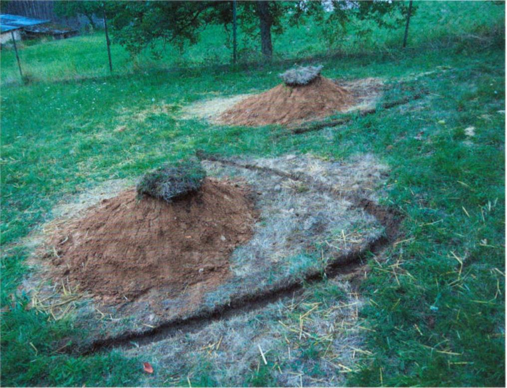
*Abb. 10: Abschließend wurden über den beiden Gruben kleine Hügel errichtet. Hangaufwärts sollen V-förmig angelegte Gräbchen für eine zusätzliche Wasserableitung von Regenwasser sorgen. – Finally, small hills were built over the two pits. V-shaped ditches should additionally drain the rainwater.*
