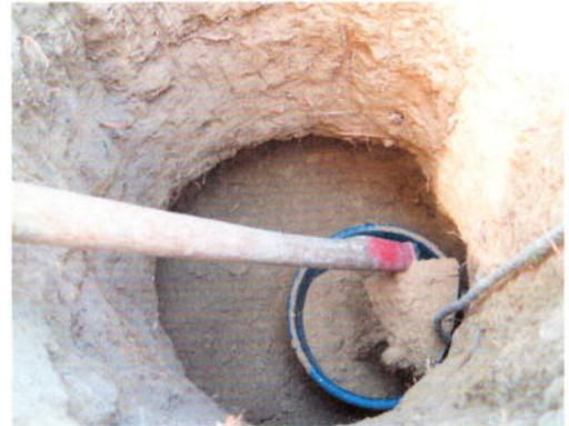
Abb. 3: Bei größerer Tiefe erfolgte das Herausheben der gelockerten Erde mittels einer langstieligen Hacke und eines Eimers. – At greater depths, the removal of the loosened soil was carried out by means of a long-handled hoe and a bucket.
