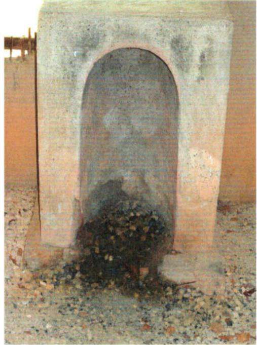
Abb. 3: Magdalensberg, Blocknischenofen in einem Handwerkerhaus vor einer Wand aus lehmverputztem Flechtwerk; links oben ist das feuergefährliche Flechtwerk der Wand zu sehen. – Magdalensberg, "Blocknischenofen" in a craftsman's-house in front of a wall made of inflammable clay-plastered wickerwork.
