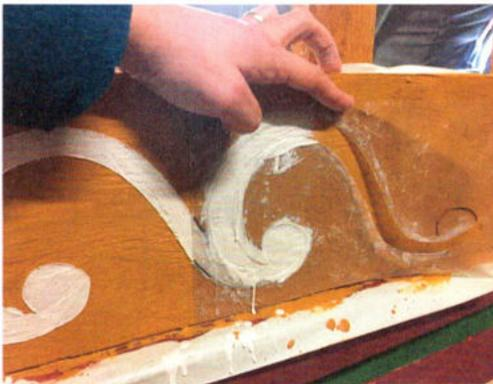
Abb. 7: Anbringung des Ornaments mit einer Schablone. – Applying an ornament with a stencil.
