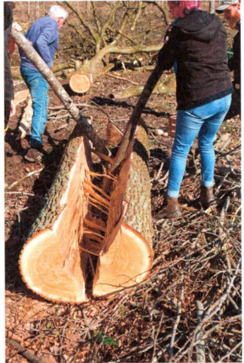
Abb. 6: Geht der Spaltriss durch, kann der Stamm mit langen Stangen vollends aufgehebelt werden. – If the split crack goes through, the trunk can be completely levered with long poles.
