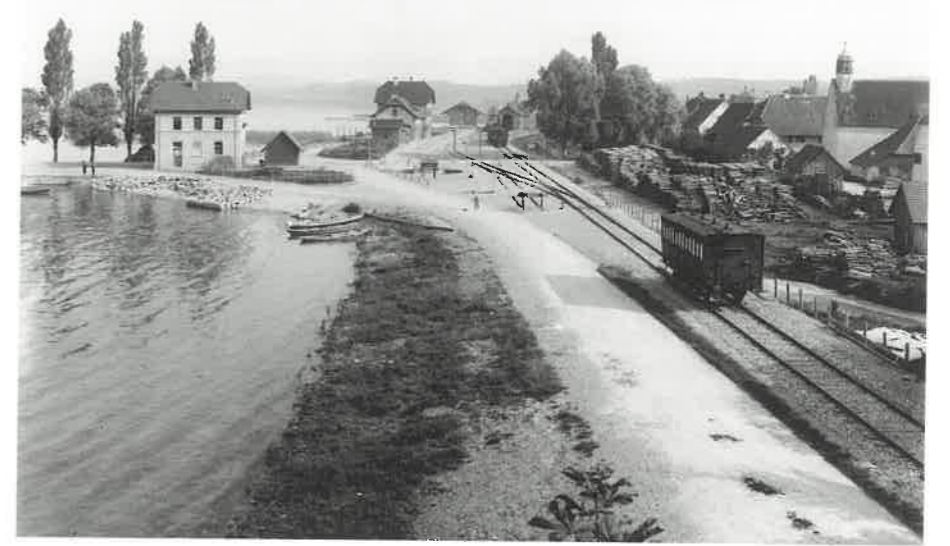
Blick von Süden auf die Versorgungseinrichtungen (3)
