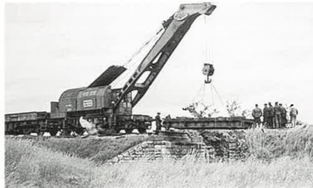
Abbau der Eisenbahnbrücke bei Oberuhldingen (6)
