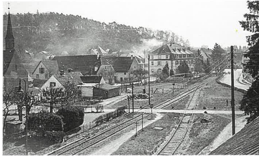
Blick aus dem Bahnhof Richtung Süden auf die Gleisanlagen (5)
