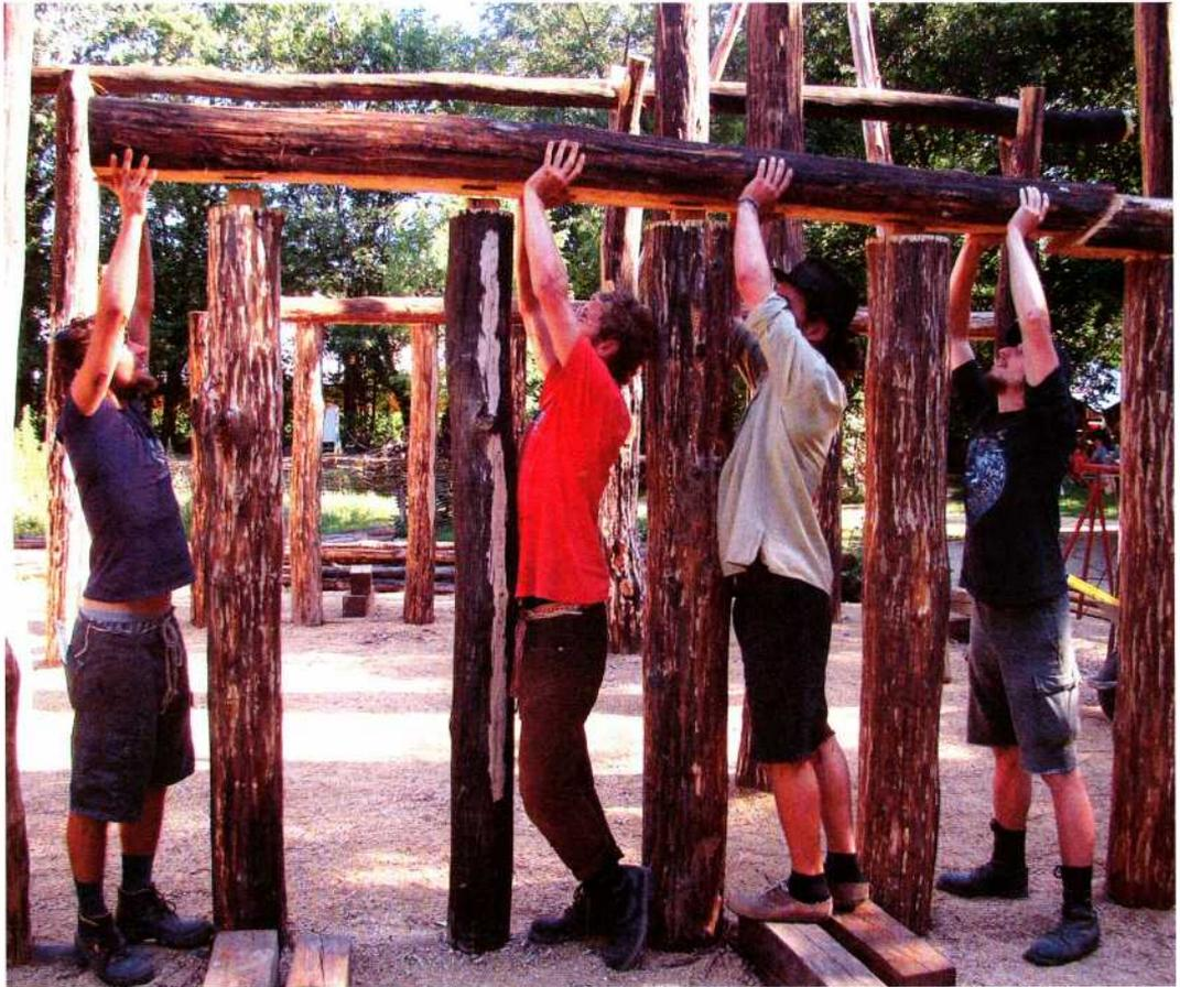
Abb. 6: Die Unterseiten der Fußpfetten wurden mit Dechseln flächig überarbeitet und mit rechteckigen Löchern versehen, um die Zapfen an den oberen Enden der Seitenpfosten aufzunehmen. – The undersides of the wall plates were flattened with adzes and showed rectangular holes to take up the central tenons on the upper sides of the wall posts.
