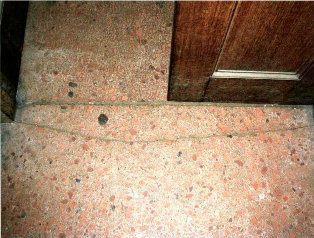
Abb. 6: Spannungsriss im Estrich (trotz einer, allerdings fest verschlossenen, neuzeitlich geplanten Fuge im Türbereich), AP Xanten, Herbergsthermen. – Crack formation (in spite of a modern, tightly closed, interstice in the door area); AP Xanten, Herbergsthermen.
