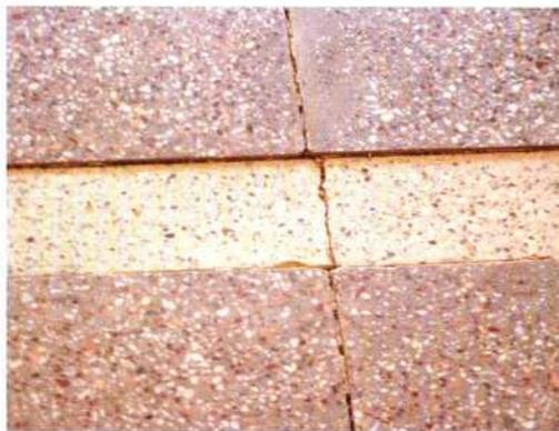
Abb. 4: Risse und Höhenversatz im Boden der Basilika Thermarum. – Clefts and differences of level in the floor of basilika thermarum.
