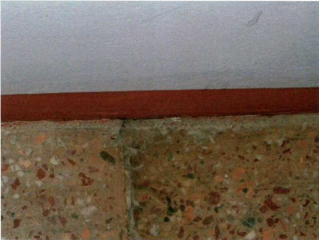
Abb. 11: Riss im Boden des Tepidariums mit für Rauchgas typischer bräunlicher Verfärbung. – Cleft in the floor of the tepidarium and brown discolouration by flue gas.
