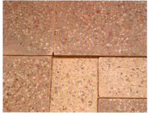
Abb. 10: Risse und Höhenversatz im Boden des Tepidariums. – Clefts and differences in level in the floor of the tepidarium.
