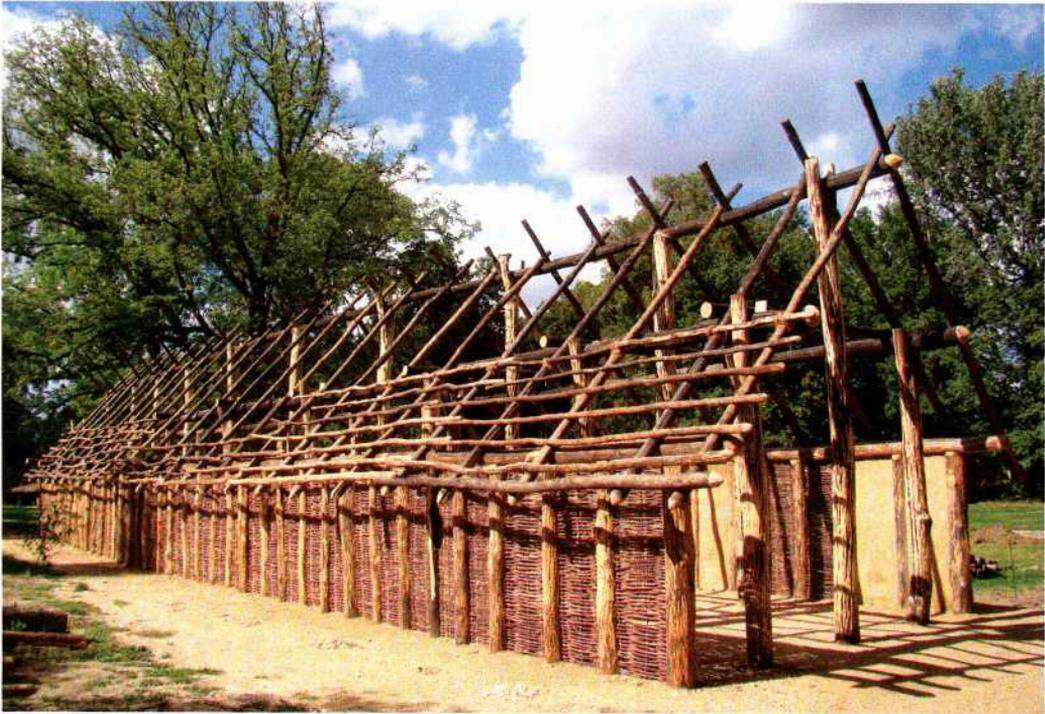
*Abb. 7: Die Konstruktion unseres Hausmodells mit Pfosten, Pforten, Binderbalken, Rofen und Latten; einige Wandfächer zeigen bereits Flechtwerk und Lehmverputz. – The construction of our house model with posts, wall plates, purlins, tie beams, rafters and lath woods; some parts of the wall show already wattle and clay plaster.*
