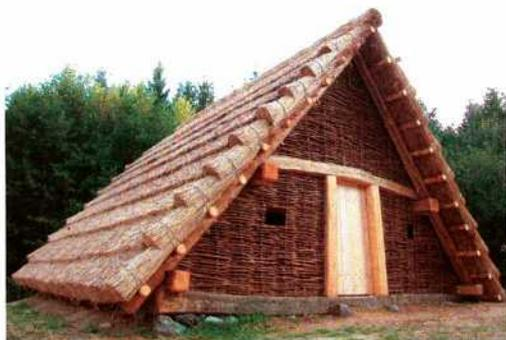
*Abb. 7: Unser Grubenhausmodell mit Schilfdach, Wendebohlentür und Flechtwänden vor dem Verputzen derselben; im Inneren wurde eine Holzwerkstätte eingerichtet. – Our pit house model with reed roof, ledged door leaf and wattle walls before plastering; in this house a wood workshop was installed.*
