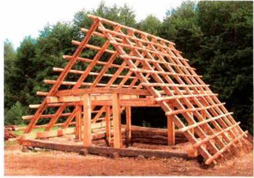
*Abb. 6: Dieses Grubenhausmodell wurde nach einem archäologischen Befund aus Hidegség bei Sopron errichtet und zeigt eine Satteldachkonstruktion; die Grubenwandung im Inneren wurde durch horizontale Eichenstämme gegen seitlichen Verstoß gesichert. – This pit house model was done after an archaeological evidence from Hidegség near Sopron and shows a saddle roof construction; the inner earth walls were safeguarded with horizontal oak beams against erosion.*
