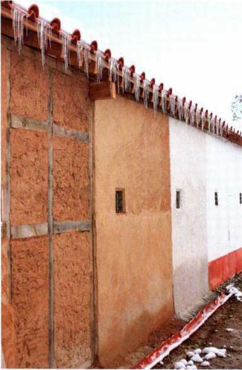
*Abb. 10: Die Westseite der Fabrica dient als Versuchsfläche. Hier wird ermittelt, wie dauerhaft verschiedene Oberflächen sind. – The western front of the fabrica is a test zone, that will show how stable different surfaces are.*
