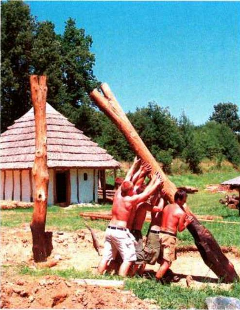
Abb. 8: Sechs Männer stellen die tragenden Firstpfosten des Webhauses auf, welches nach einem archäologischen Befund von Thunau am Kamp errichtet wurde. – Six men are erecting the earth-fast ridge posts of the weaving house, which was constructed concerning to an archaeological evidence of Thunau in Lower Austria.
