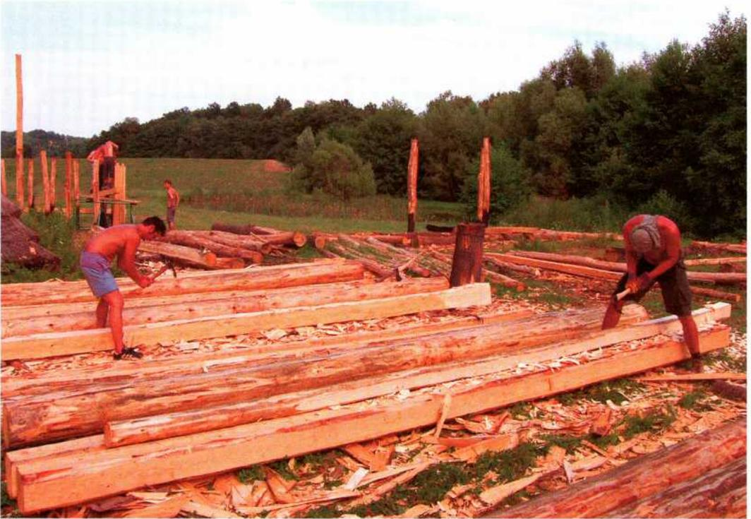
*Abb. 4: Bei experimentellen Versuchen zur flächigen Bearbeitung von Bauhölzern wurden neben Äxten und Bartäxten auch Dechseln eingesetzt. – Our experiments concerning the flatening of rectangular building woods were done with axes and adzes.*
