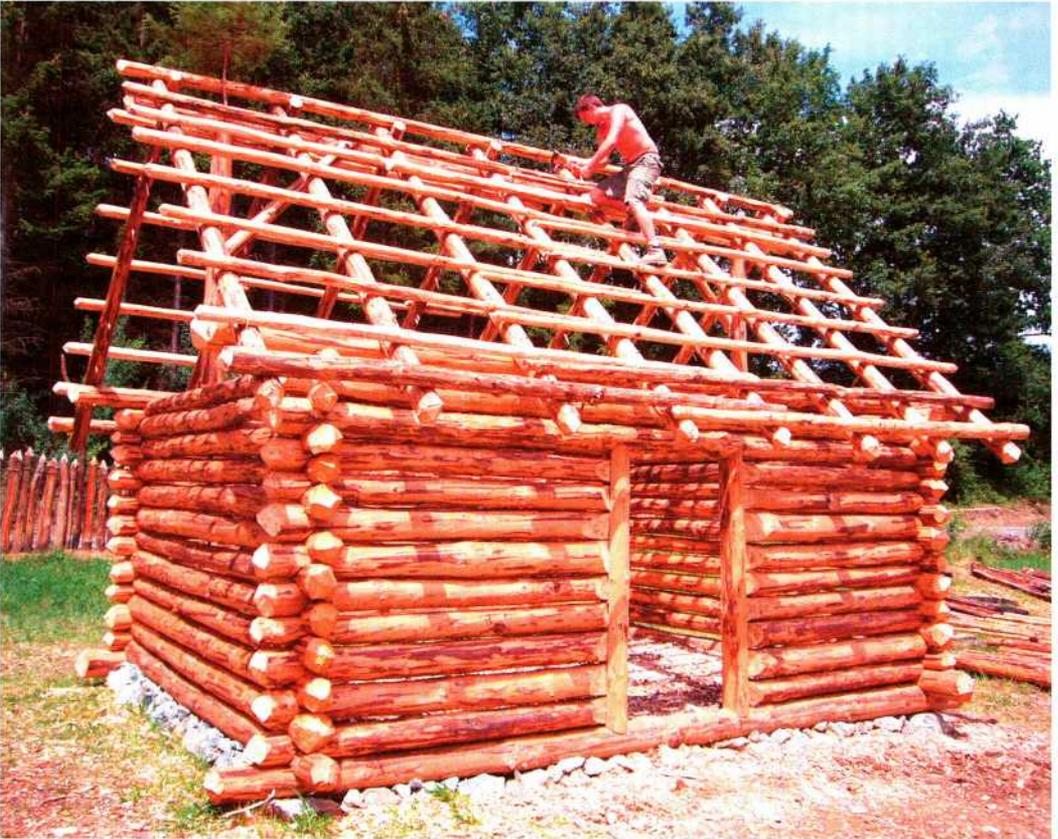
*Abb. 14: Die Holzkonstruktion des Blockbaus mit Streben, Rofenbäumen und Lattenhölzern; die obersten Längsbalken der Blockbauwände kragen an den Stirnseiten etwas vor und dienen als Fußpfetten; alle Holzverbindungen wurden mit Holznägeln gesichert. – The timber building of the log construction with braces, rafters and laths; the uppermost pair of longitudinal beams is jettied on the ridge sides and serves as wall plates; all joints are safeguarded with wooden pegs.*
