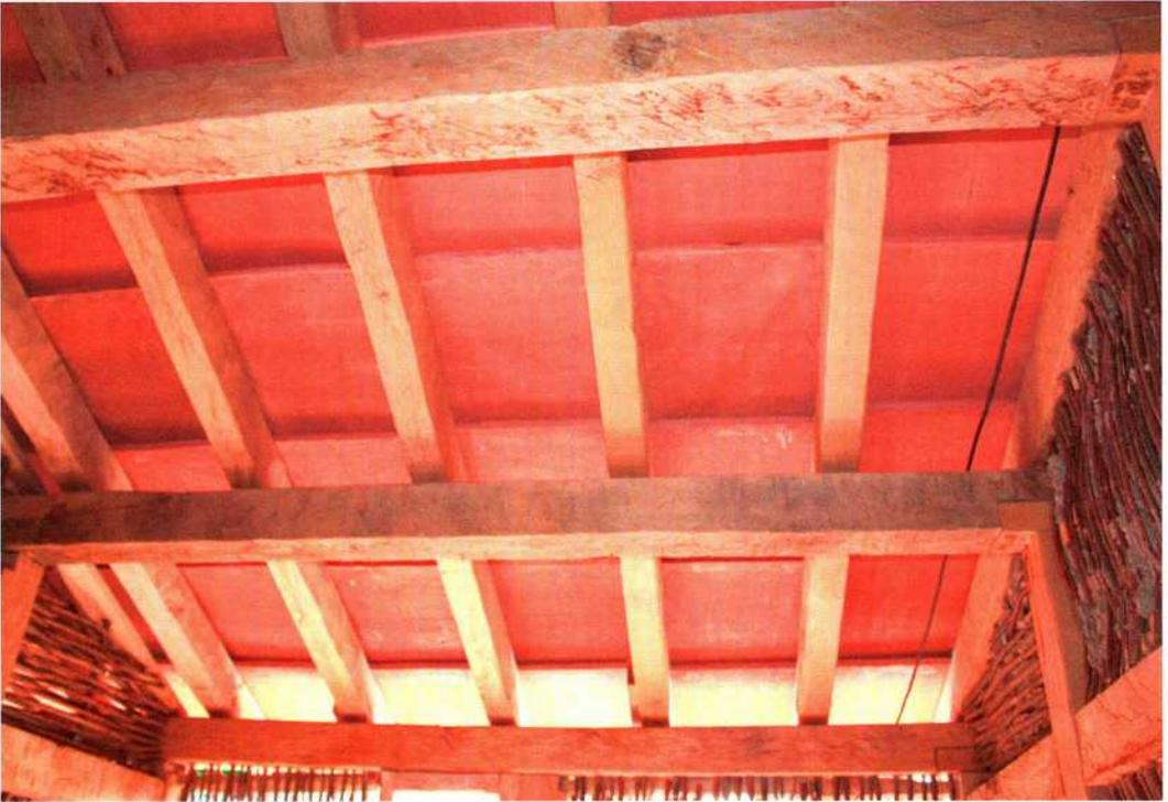
*Abb. 6: Blick von unten auf das Dach. Die Tegulae sind 45 x 55 cm groß und liegen direkt auf den Sparren, ohne Dachlatten. – View from below to the roof. The tegulae measure 45 x 55 cm and lie upon the rafters, without roof laths.*
