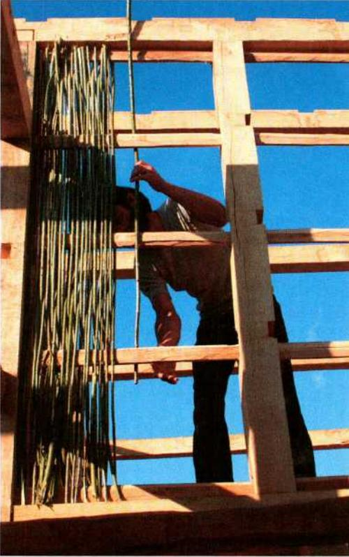
Abb. 8: Die Weidenruten werden senkrecht eingeflochten. – The ozier stakes are watted vertically.
