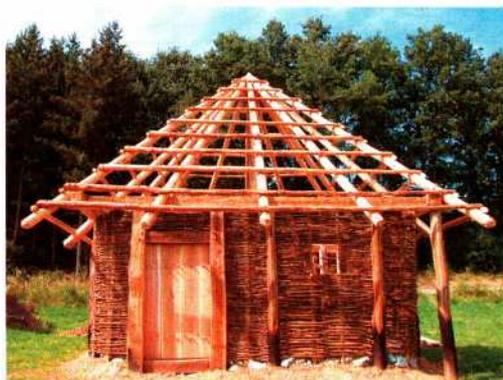
Abb. 10: Die Holzkonstruktion unseres Wohnhauses in Pfostenbautechnik mit Türbereich und Flechtwerkwänden; das archäologische Vorbild für dieses Hausmodell stammt aus Baumgarten an der March in Niederösterreich. – The wooden construction of our living house in post building technique with door area and wattle walls; the archaeological evidence for this house model stems from Baumgarten in Lower Austria.
