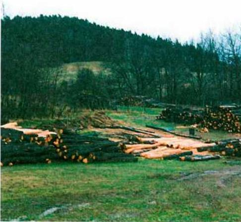
*Abb. 5: Ein Teil der 2.700 vorbereiteten Stämme mit abgesägten bzw. angespitzten Zopfenden; stärkere und geschälte Stämme wurden für die Tore verwendet.*
