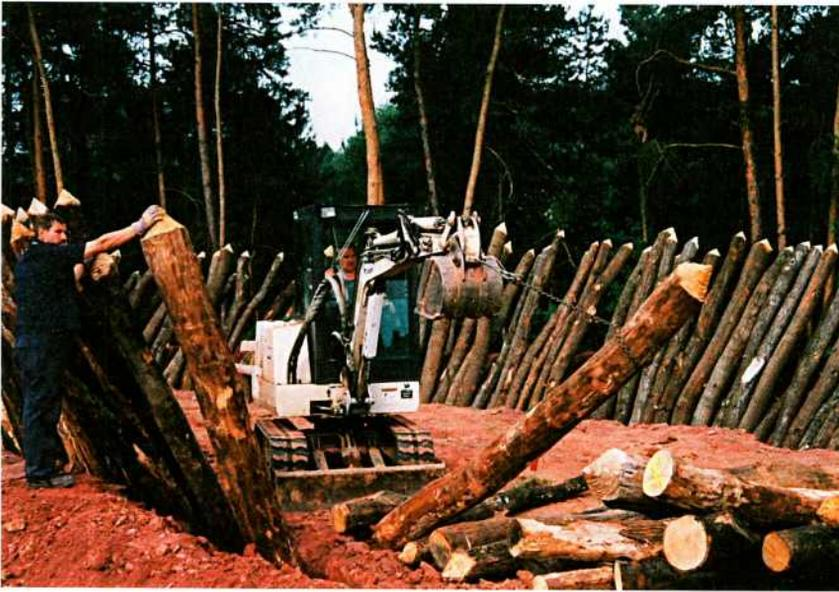
*Abb. 9: Setzen der Stämme mit Hilfe eines Minibaggers in den Palisadengraben.*
