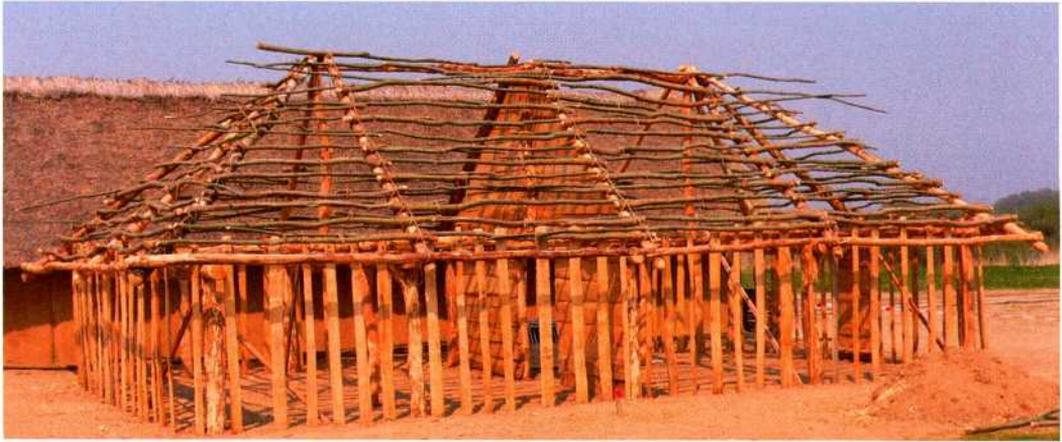
Abb. 5: Rekonstruktion des Gerüsts von Haus 3.
