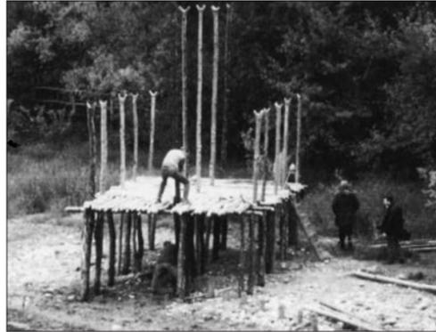
Am folgenden Tag (21.5.96) kamen die anderen Firstpfähle (Abb. 22), gegen Mittag die Wandpfetten (Abb. 23), die Firstpfette (Abb. 24) und die Dachsparren (Abb. 25) hinzu.
