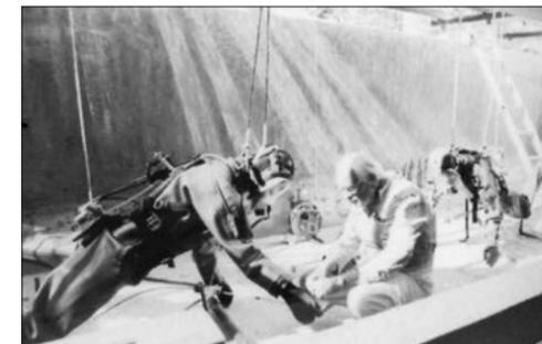
Abb. 10 (oben): Überprüfung der Bewegungsfunktionen im noch ungefüllten Taucherbecken.
