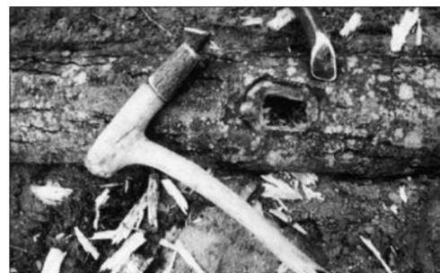
Zur Aufnahme der Pfetten wurden einige Pfähle am Kopfende gabelförmig ausgearbeitet (Abb. 19).
