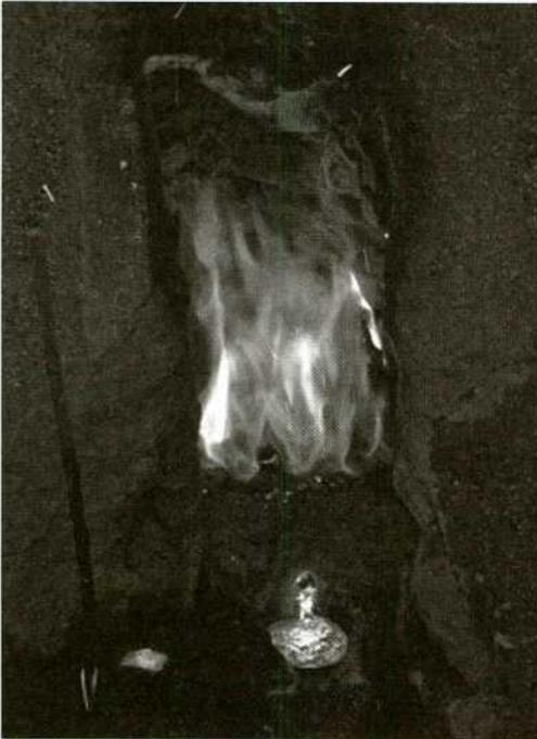
Abb. 17: Ablassen des flüssigen Kupfers aus dem Schachtofen in eine vorgelagerte Mulde.
