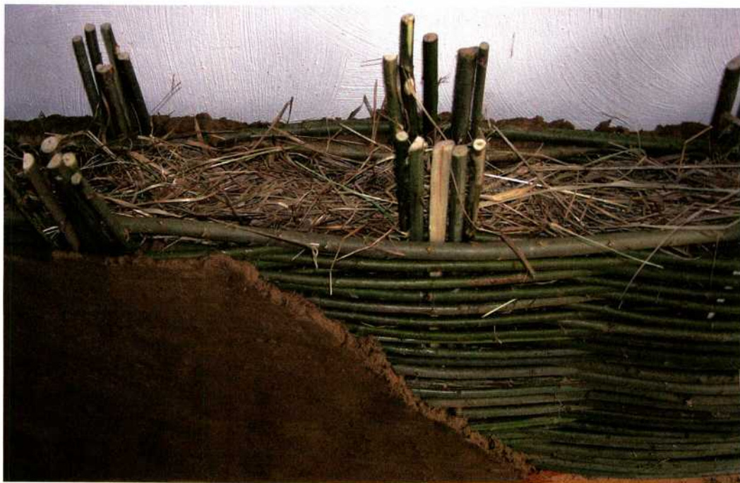
Abb. 1: Nachgebaute doppelte Flechtwand mit Grasfüllung und Lehmbewurf (Ausstellung „Leben in der Bronzezeit“ beim Hessentag und im Museum Langenselbold).
