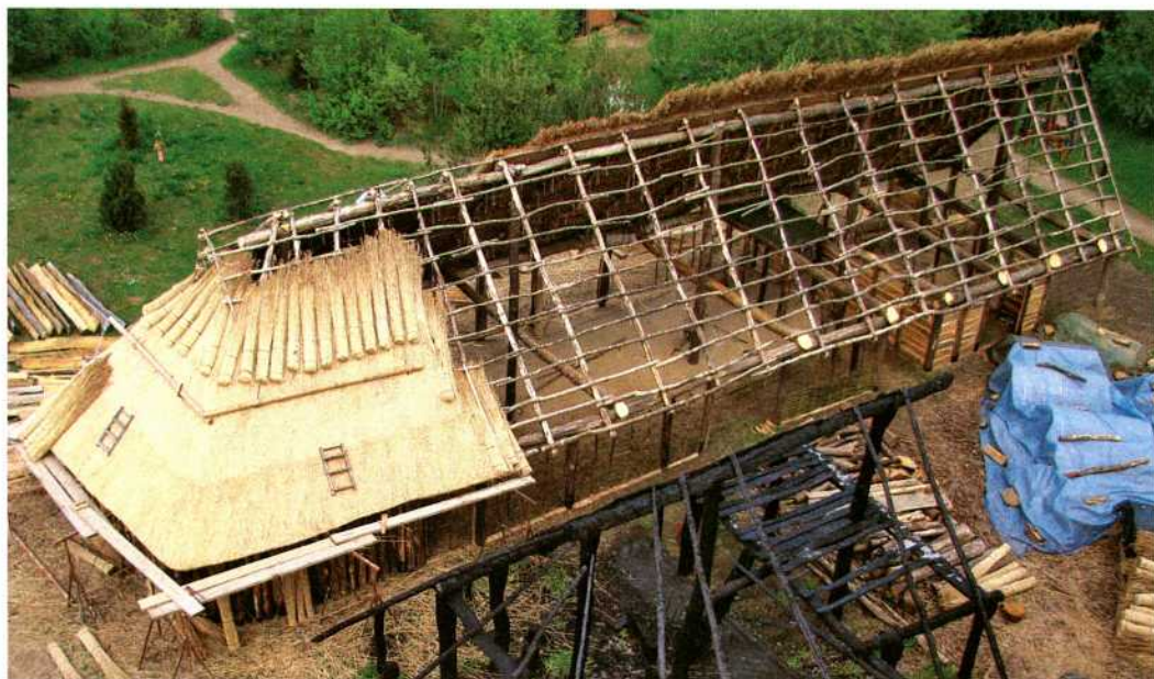
Abb. 8: Das Langhaus während der Bauarbeiten aus der Vogelperspektive; ein Teil des Reetdaches ist bereits aufgebunden; rechts sind die Spaltbohlenwände gut erkennbar; im Vordergrund ein Teil der Brandruine.
