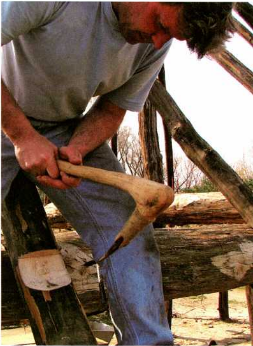
Abb. 6: Die Rofen wurden an ihrem unteren Ende durch Aufklauungen mit den Wandpfetten verbunden; die Klauen wurden vor allem mit quer geschäfteten Bronzeklingen, sog. Dechsele gearbeitet.
