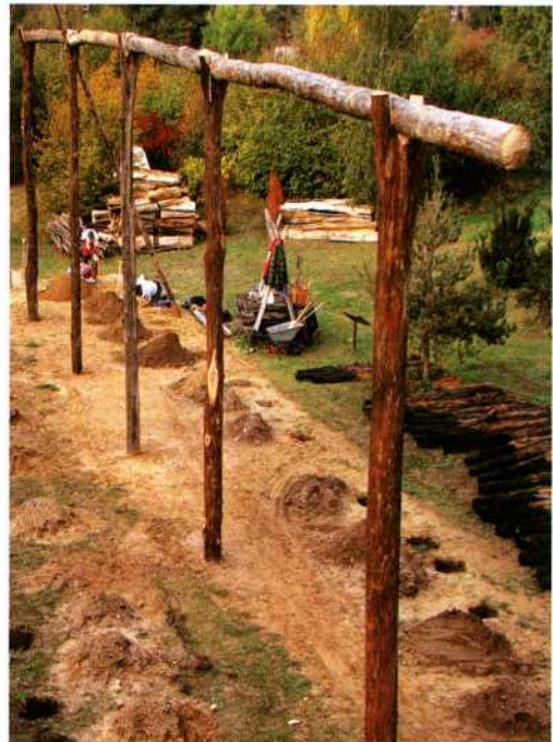
Abb. 4: Die Firstpfettensegmente wurden in die Gabelenden der Firstpfosten eingelegt und durch schräge Überblattungen, sowie durch Seilbindungen miteinander verbunden; vorne links sind Gruben für die Wandpfosten erkennbar.
