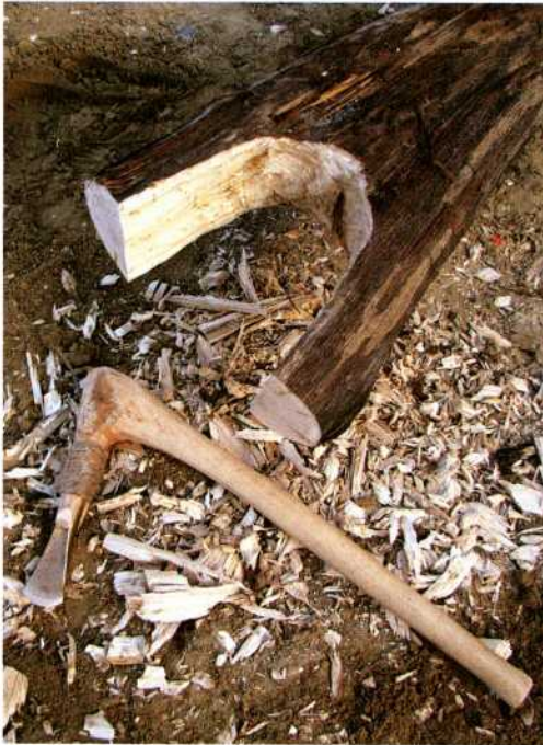
Abb. 3: Die gewachsenen Gabelenden der Firstpfosten wurden an die Rundungen der Firstpfetten angepasst; Randleistenbeile waren dafür besonders gut geeignet.
