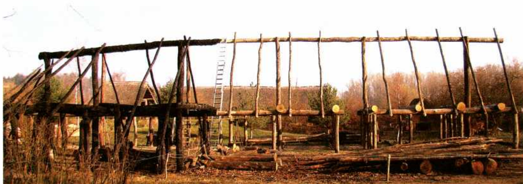
Abb. 7: Wand- und Firstpfetten dienten als Auflager für die Rofenbäume der Dachkonstruktion; vorne links ist noch ein Teil des abgebrannten Hauses zu sehen.
