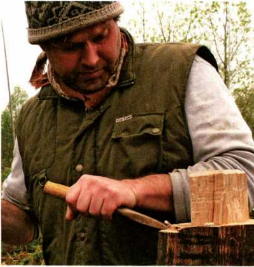
Abb. 5: An den oberen Enden der Wandpfosten haben wir rechteckige Zapfen angebracht, die mit Stemmeißein aus Bronze gefertigt wurden.
