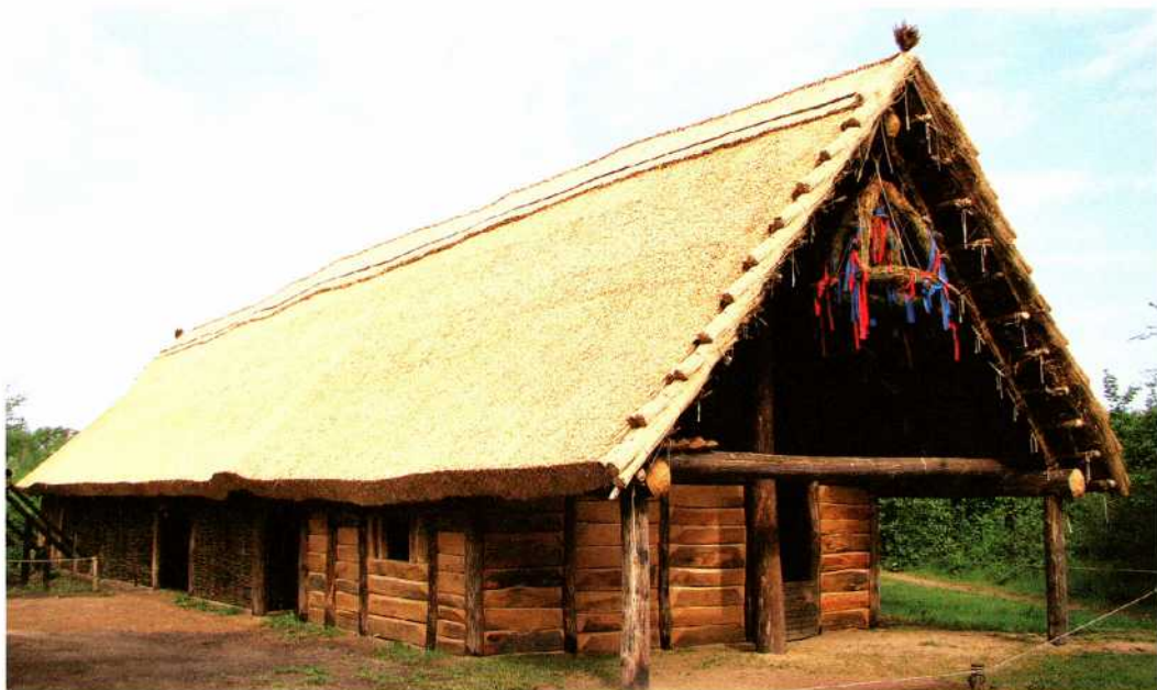
Abb. 13: Das Langhausmodell von Südosten mit Reetdach, Flechtwerk- und Spaltbohlenwänden; deutlich erkennbar ist die Aussparung für das Fenster in der Bildmitte.
