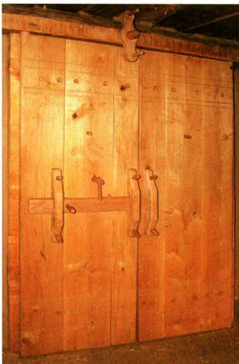
Abb. 12: Zweiflügelige Tür, die vom Durchgang in den größeren Raum im Westen führt; die runden Zapfen an den äußeren Ecken der Türblätter sind im Türstock gelagert und ermöglichen ein problemloses Öffnen und Schließen derselben. Die Tür zeigt eine einfache Verriegelung aus Holz.
