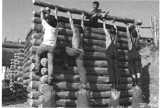
Abb. 13: Die oberen Balkenlagen mussten mühsam von Hand hochgehoben werden.
