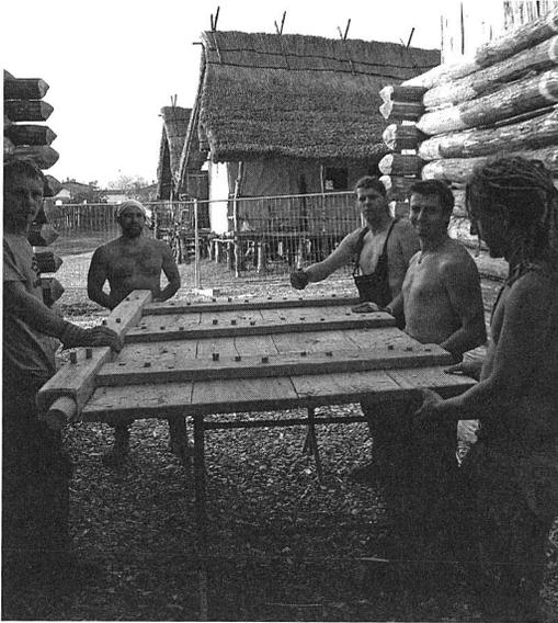
*Abb. 17: Fünf Personen waren nötig, um einen unserer Torflügel mit einem geschätzten Gewicht von 150 kg in Position zu bringen und in die dafür vorgesehenen Ausnehmungen einzulassen.*
