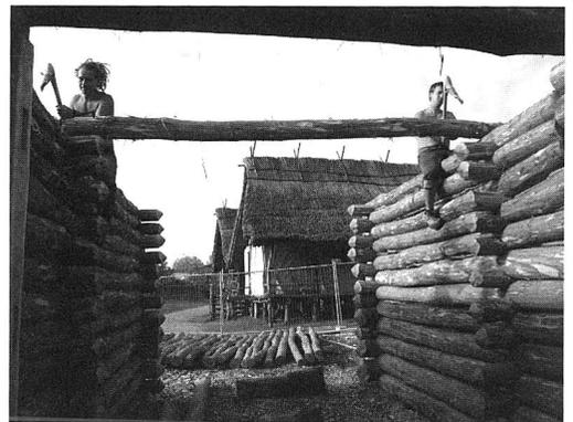
Abb. 14: Querbalken über der Torgasse bildeten die Basis für eine Brücke; an ihnen wurden auch die Flügel des Tores befestigt.
