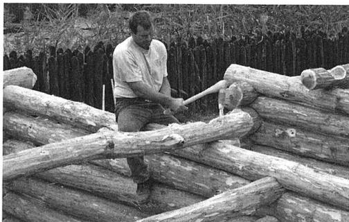
*Abb. 9: Die schweren Randleistenbeile aus Bronze wurden auf natürlich gewachsenen Kniehölzern geschäftet und erwiesen sich als brauchbare Geräte zum Bau von Blockbauten.*
