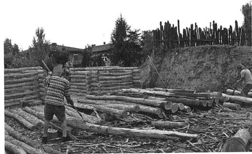
Abb. 8: Vor dem Einbau der Stämme in die Blockbaukästen wurden die Hölzer geschält.
