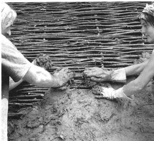
Abb. 13: Die Flechtwerkwände des Webhauses werden mit einer Mischung aus Lehm, Sand, Stroh und Wasser abgedichtet.
