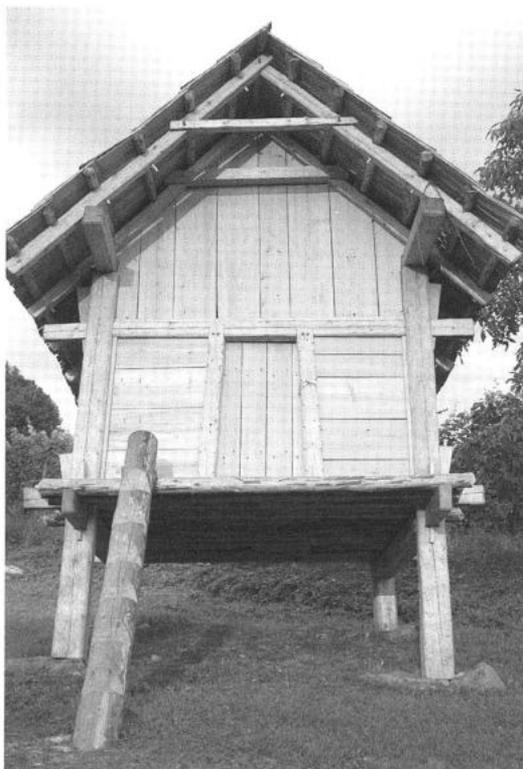
Abb. 19: Rekonstruktion des Hochspeichers mit Riegelwänden, Eingangsplattform, Wendeböhlentür und Steigbaum.
