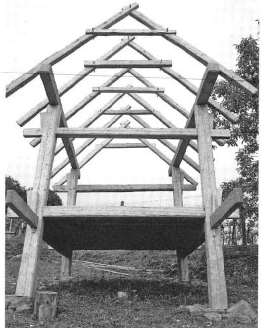
Abb. 17: Rekonstruktion des Hochspeichers mit Ständern auf Unterlegsteinen, Zapfen-schlosskonstruktionen und Sparrendach mit Kehlbalken.
