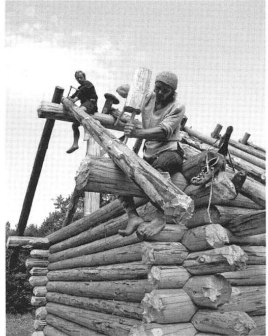
Abb. 6: Die Rofenbalken wurden mit gespaltenen Holznägeln aus Eichenholz an den Dachpfetten befestigt.
