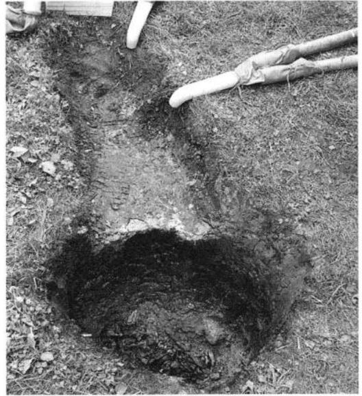
Abb. 15: Die Gussgrube besteht aus einem tiefen Teil für die Form und einem flachen Teil für den Tiegel.
