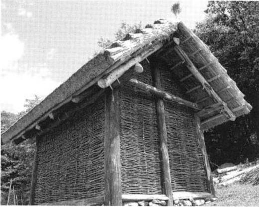
Abb. 11: Webhaus in Pfostenbauweise mit Flechtwänden und Schilfdach von Süden.
