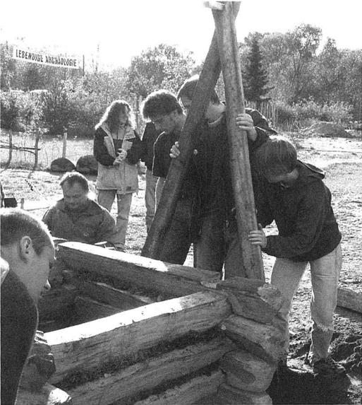
Abb. 9: Aufstellen des Umlenkholzes auf X-Trägern am 18. Arbeitstag.
