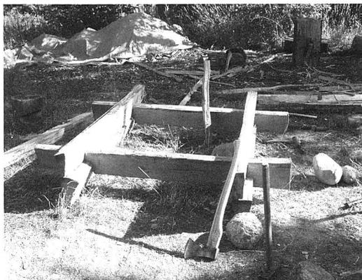
Abb. 2: Die ersten drei Bohlenpaare sind verblockt, der Höhenunterschied um jeweils eine halbe Bohlenbreite ist deutlich erkennbar, ebenso die Schnur als Mittellinie.
