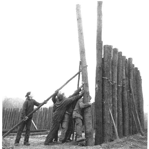
Abb. 9: Die innere Palisadenreihe des Kreisgrabens besteht aus ca. 420 Eichenpfosten, die von Hand aufgestellt wurden.
