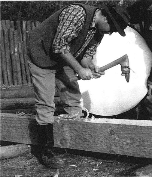
Abb. 11: Die rechteckigen Einzelposten des äußeren Palisadenrings wurden mit quer geschäfteten Steindeckseln in Form gebracht.
