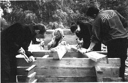
Abb. 5: Zurichten und Verblocken der Bohlen.
