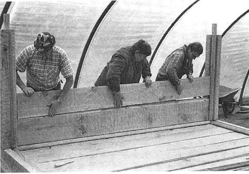
Abb. 7: Einsetzen der Wandbohlen.
