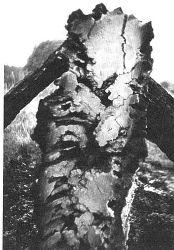
Abb. 8: Klein Körös, Wandsegment. Das Weidenflecht ist vollständig weggebrannt, an den Seiten stehen noch die „Dachsparren“.
