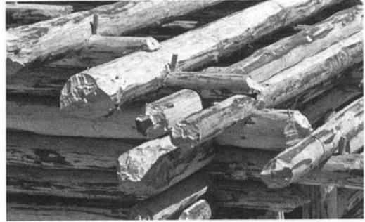
Abb. 5: Beim Blockpfetten- oder Ansdach werden die Längsbalken ab der gewünschten Raumhöhe nach innen versetzt aufgelegt und bilden so die Dachkonstruktion.
