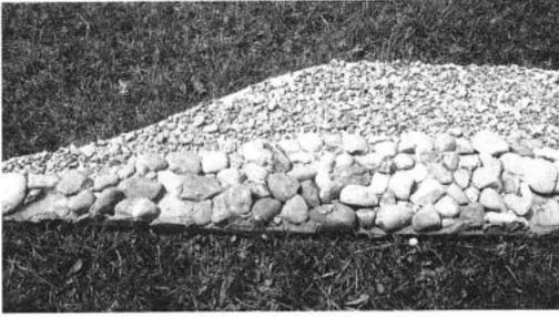
Abb. 17: Rekonstruierter Schnitt durch die Via Claudia (unten grobe Steine, oben feiner Kies, teilweise mit Mörtel vermischt).
