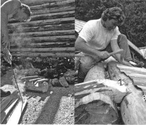
*Abb. 7: Mit einem Dorn aus Bronze wurden Löcher in die gespaltenen Lärchenschindeln eingebrannt.*
