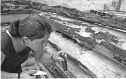
Abb. 10: Die Fugen zwischen den Balkenlagen wurden mit frischem Moos abgedichtet.
