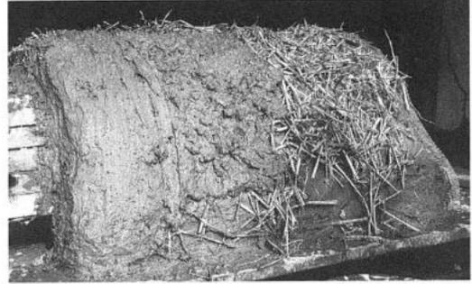
Abb. 21: Nach einer ersten Lehmschicht wird der Ofen mit Stroh bestreut. Darüber trägt man eine zweite Lehmschicht auf.
