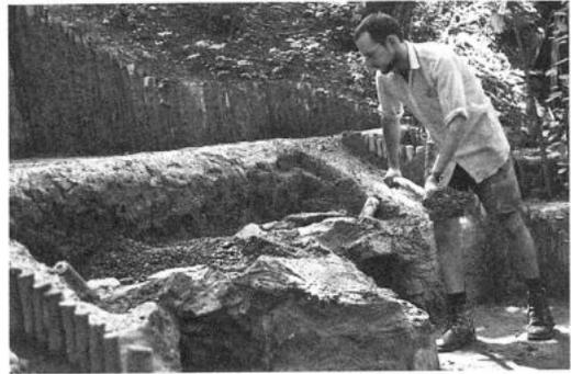
Abb. 7: Hinterfüllen der Steinschale mit Kies und Lehm auf der Höhe des steinernen Tragbalkens.
