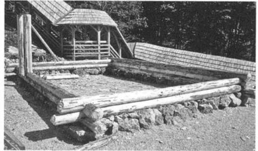
Abb. 3: Die ersten zwei Balkenlagen mit den seitlich geschlitzten Türrändern.
