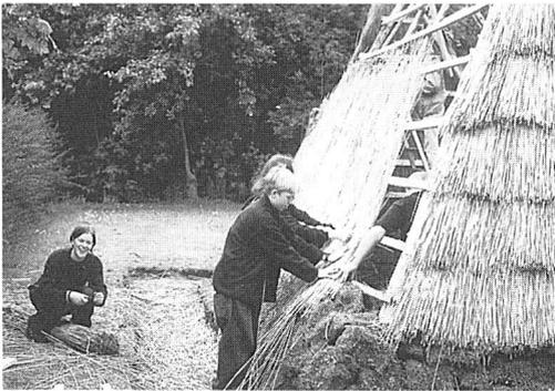
Abb. 3: Das vorbereitete Ried wird auf das Lattengerüst gebunden.
