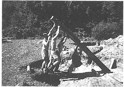
Abb. 4: Die Pfosten der Gebäude wurden von Hand aufgestellt.
