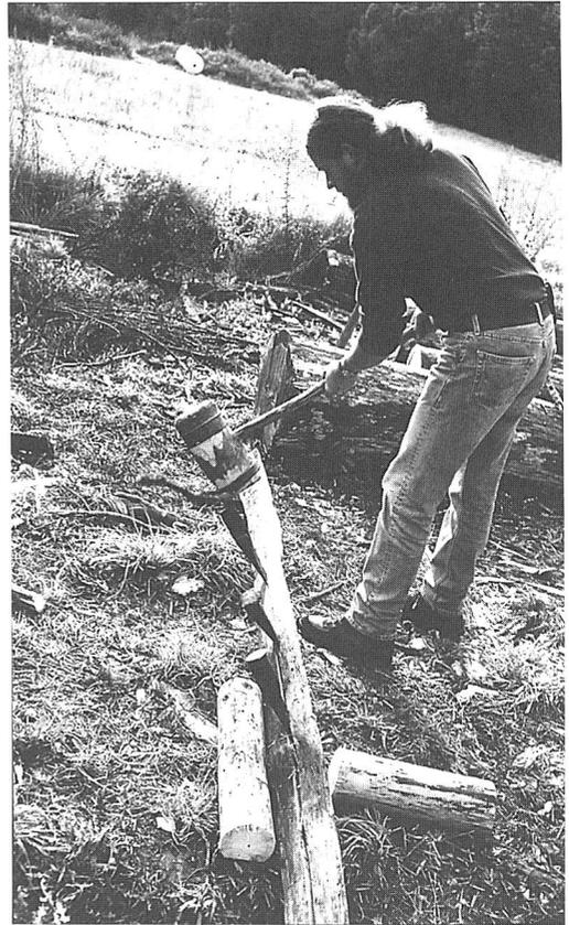
*Abb. 2: Die Herstellung von Spalthölzern mit Schlögell und Holzkeilen.*
