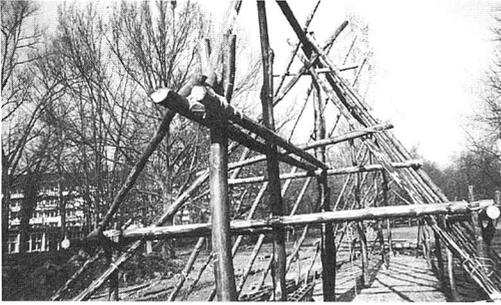
Abb. 16: Rofen wurden aufgelegt. Die Dachneigung wird durch die Konstruktion bestimmt und muss nicht festgelegt werden.
