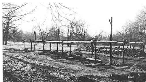
Abb. 14: Der erste Bauabschnitt (Innenkonstruktion) ist fertig, alle Pfetten laufen in 1 Gm Höhe parallel zum Begehungshorizont. Die Giebelpfosten (2 Gm hoch) sind gesetzt.
