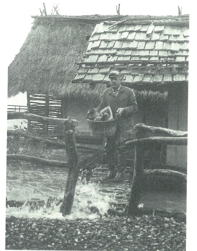
Das Mobiliar wird herausgetragen, die Wellen überschlagen den Zugangssteg zum „Arbonhaus“.
