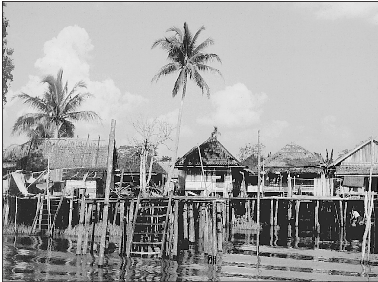
Abb. 7: Pfahlbau-Siedlung auf dem natürlichen Fluß- damm des unteren Sungei Musi (Süd-Sumatra). Die am Unterlauf der großen Tieflandsströme der immerfeuchten Tropen nur schwach aufgehöhten, natürlichen Flußdämme und der nach den jahreszeitlichen Spitzen der Regenfälle stark ansteigende Wasserstand erfordern den Bau auf 4 - 6 m hohen Pfählen. Die Häuser sind durch Plattformen und Stege verbunden, von außen aber nur per Boot erreichbar. Reisbau in den dahinterliegenden Rückstausenken („lebak“), dazu Fischerei, Flußhandel usw. Foto: H. Uhlig, 1971
