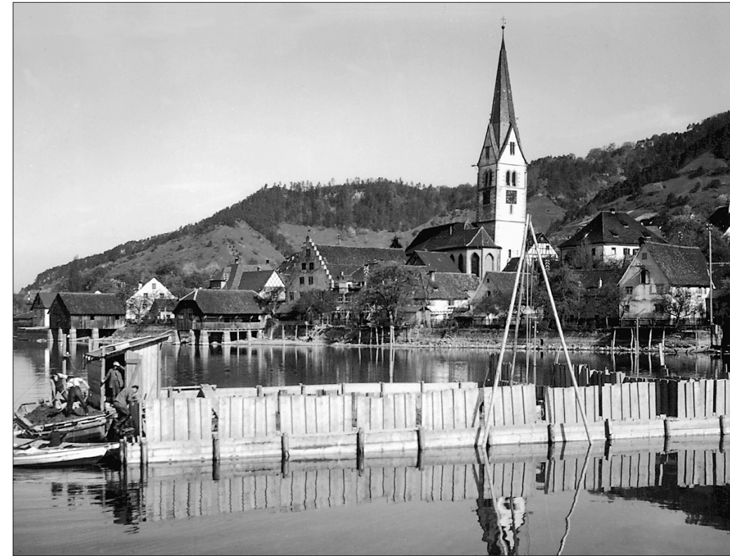
Abb. 3: Der Ausgrabungs- kasten vor Sipplingen beim Aufbau im April 1929. Vom Last- kahn aus wird Lehm zur Abdichtung in die zwei- schaligen Kastenwände eingefüllt.
