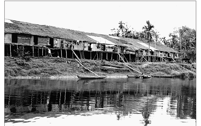
Abb. 13: Langhaus der Iban in Sarawak (Ost-Malaysia). Auch die traditionellen Langhäuser der Dayak-Völker Borneos sind auf hohen Pfählen errichtet, besonders gern auf den natürlichen Flußdämmen, hier des Lupa-Flusses. Vorgelagerte Plattform als Laufgang zu den einzelnen Familien-Abteilen. Leitern aus gekerbten Baumstämmen ermöglichen den Zugang zu der Plattform und zum Fluß mit seinen stark schwankenden Wasserständen. Foto: H. Uhlig, 1966
