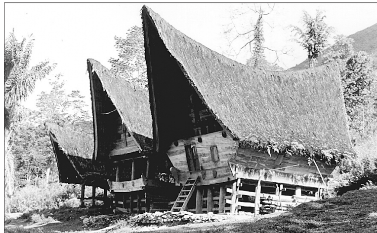
Abb. 8: Häuser der Toba-Batak, Nord-Sumatra. Beispiel der vielfältigen, kunstvollen Bauten der alt-indonesischen Bergvölker (stark durch ethnokulturelle Motive geprägt). Der Pfahlbau wird – wie in mehreren Parallelfällen, z.B. bei den Toraja – durch fachwerkartige Querverstrebungen stabilisiert. Auch die geschwungene Dachform (darunter die Vorratsräume) kehrt z.B. bei den Häusern der Toraja oder denen der Minangkabau (West-Sumatra) in ähnlichen Formen wieder. Foto: H. Uhlig, 1967
