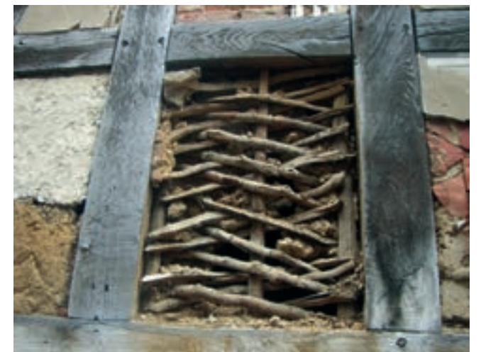
Abb. 2: Neuzeitliche Ausfachung einer Fachwerk- wand in Rauischholzhausen. Foto: I. Staeves.
