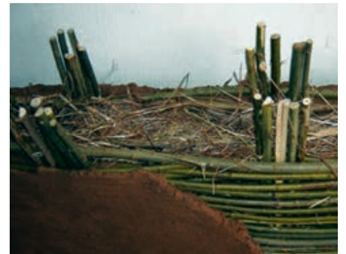
Abb. 1: Nachgebaute doppelte Flechtwand mit Grasfüllung und Lehmwurf (Ausstellung „Leben in der Bronzezeit“ beim Hessentag und im Museum Langenselbold). Foto: H.-O. Schmitt.
