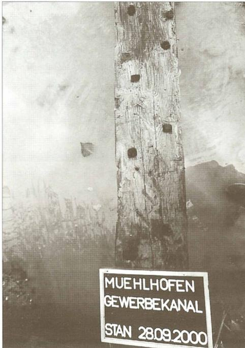
die Seitenwände Richtung Grabenmitte gedrückt werden. Wie die Querversteifungen sind sie in Schwalbenschwanztechnik in die langen Wandbalken eingefügt.
