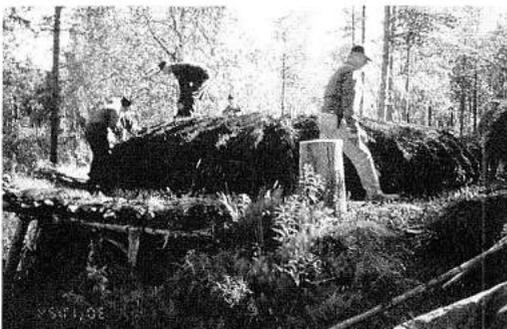
Abb. 5 Fertiger, mit Grassoden abgedeckter Meiler.
