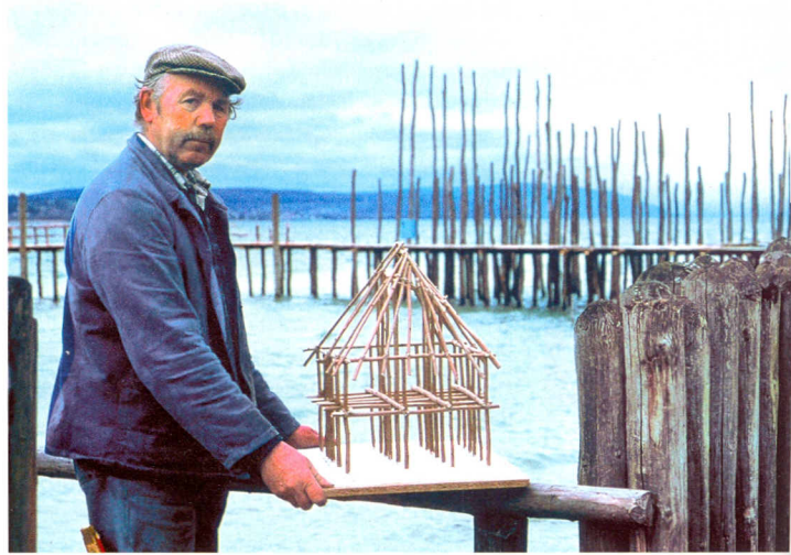
Die abgeschlossene Modellbildung des Rohbaus von Haus 1 im Maßstab 1:10.
