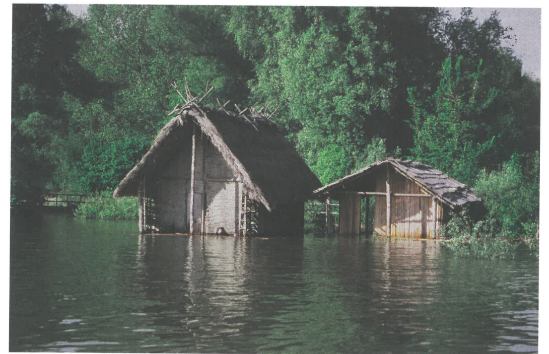
Abb. 7: Wasserschaden Jahrhunderthochwasser im Juni 1999.
