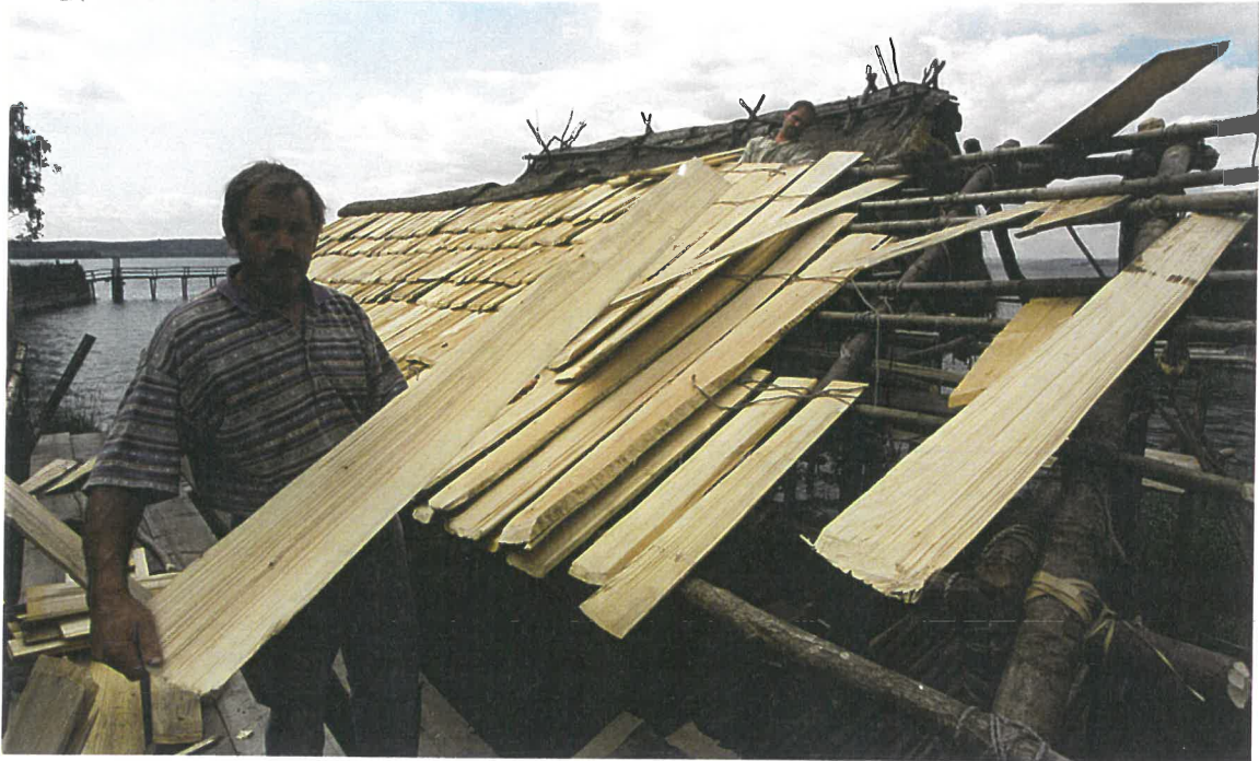
Abb.2: Weißtannenschindeln von 2,10 m Länge, Version 3, werden auf dem Dach in 3-fach Überdeckung aufgebunden. Foto Pfahlbaumuseum Unteruhldingen, Schöbel.
