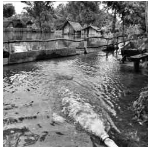
Abb. 6: Bei einem Pegel von 5.65 Meter am Pegel Konstanz ist das alte Museum und das gesamte Ufer in der Pfahlbaubucht überschwemmt. Acht Pumpen in allen Gebäuden halten den Zugang für die Besucher offen. Sandsackwälle und Bretterschutz durch aufgenagelte und mit Draht gesicherten Dielen an der Uferkante sollen gegen einen weiteren Anstieg schützen.
