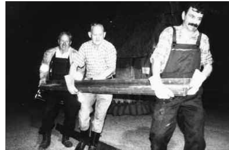
Abb. 9: In einer Nachtaktion legt die Feuerwehr Uhl-lingen-Mühlhofen mehr als hundert Meter Eisenbahnschienen, ein Meter wiegt 48 kg, als zusätzliche Beschwerung auf Plattformen und Stege.
