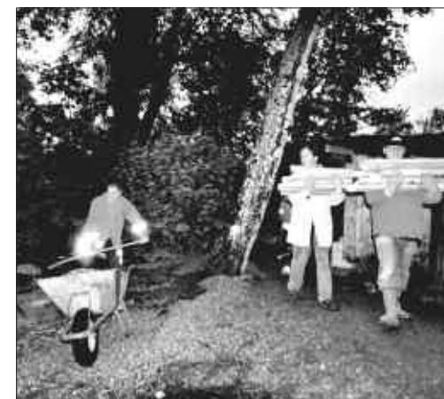
Abb. 2: Der See kommt. Das Archiv im Untergeschoss des Werkstattgebäudes muß in das Obergeschoss verlagert werden. Splitwälle und Bretterschutz sollen das Eindringen von Wasser in die Kellerräume verhindern.
