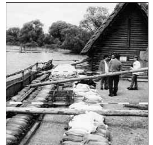
Abb. 17: Die Seeseite der Bronzezeitplattform ist gesperrt. Ein doppelter Sandsackwall, Eisenbahnschienen, Bretter und zusätzliche Holzverstreben sollen schützen.
