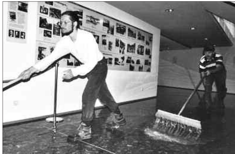
Abb. 5: Auch das neue Museum erhält über Nacht einen Wassereinbruch. Mitarbeiter helfen am Morgen beim Hinauskehren des Wassers. Die Feuerwehr saugt über den tiefer gelegenen Aufzugsschacht die Wassermassen ab.
