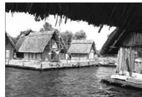
Abb. 11: Blick von den alten Häusern auf die Bronzezeitplattform. Zum Schutz gegen die Wellen werden große Schwartenbretter am Geländer der Plattformen befestigt. Bei Sturm und heftigem Wellengang ist ein Aufbrechen der Plattform zu befürchten.
