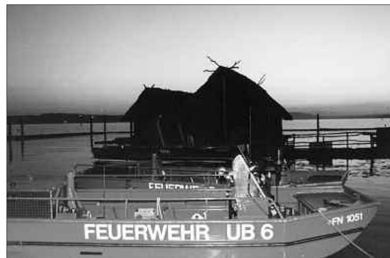
Abb. 14: Nach Sonnenuntergang steht am Freitag nach 36 Stunden Arbeit ein 250 Meter langer Wellenbrecher um die Pfahlbauten.
