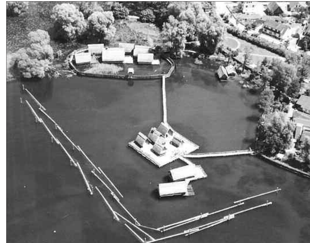
Abb. 15: Der doppelte Wellenbrecher, gebaut aus mächtigen, bis zu 150 Jahre alten Tannenstämmen, eine große Gemeinschaftsleistung von Diensten; Mitarbeitern und Freiwilligen, steht und funktioniert. Etwa 50% der Wellenamplitude werden bis etwa Windstärke 7 gebrochen.
