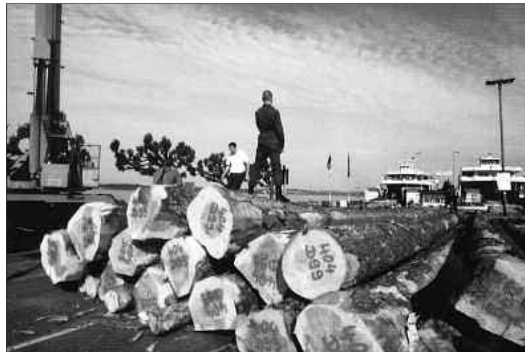
Abb. 13: Freitag, den 28. Mai 1999. Auf Anregung des Technischen Hilfswerkes und des Ortsbauamtes wird mit der Einrichtung eines Wellenbrechers rund um die Pfahlbauten begonnen. Dazu finden 25 Meter lange Weistannenstämme, die kurz vorher bei Hüfingen in der Nähe von Donaueschingen geschlagen wurden und in der Nacht unter Polizeischutz mit Schwertransportern an den Bodensee gelangten, mit einem Gesamtgewicht von 150 Tonnen Verwendung. Am Meersburger Fährhafen der Stadtwerke Konstanz können diese Schutzelemente aufgrund der hochwasserbedingten Einstellung des Fährebetriebes mit dem Schwerlastkran gewässert werden. Die Feuerwehr Überlingen, das THW und die Wasserschutzpolizei ziehen Stamm um Stamm (Einzelgewicht 3–5 to.) auf dem Seeweg nach Unteruhldingen.
