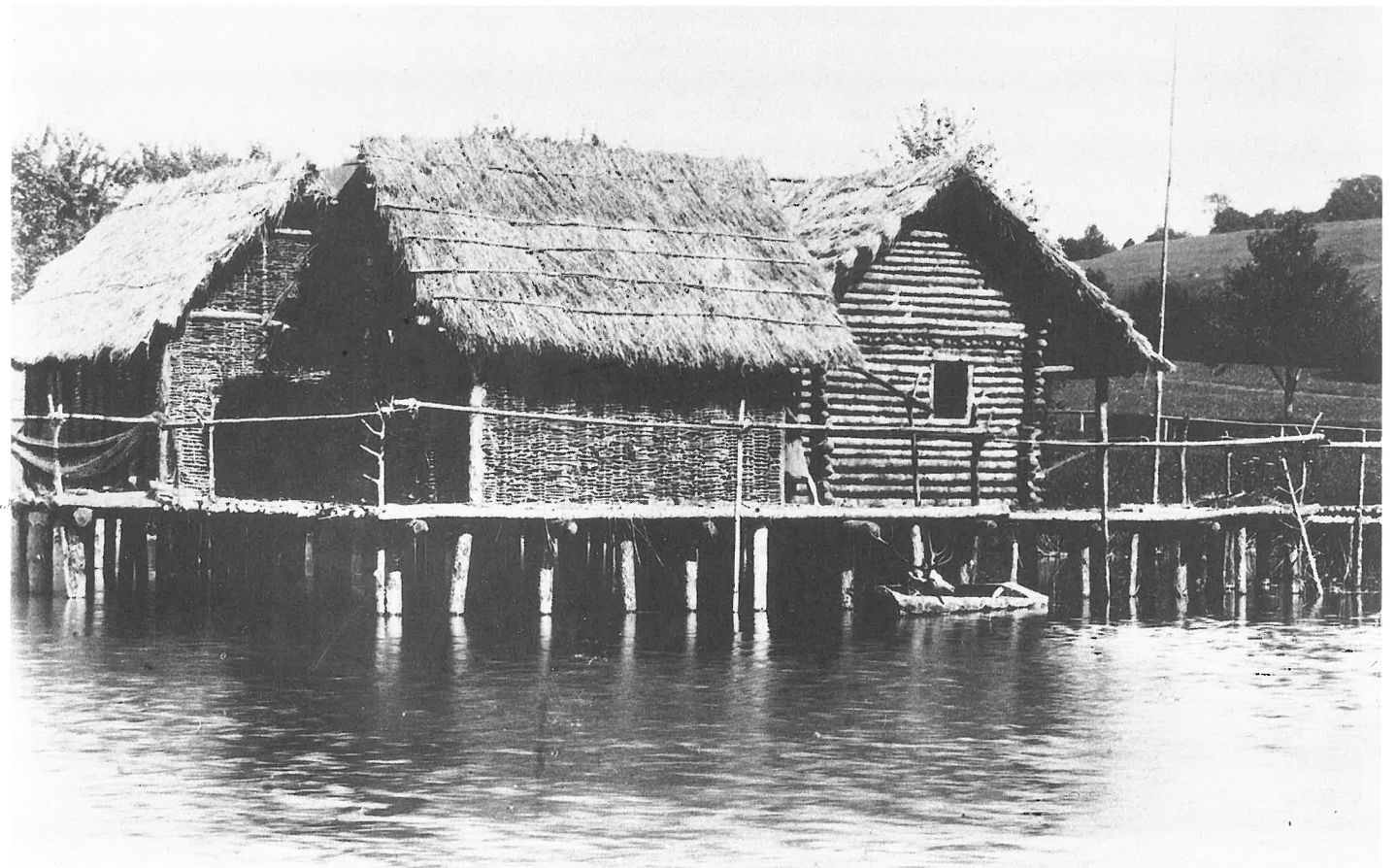
143 Die ehemalige Pfahlbaurekonstruktion in Kammer am Attersee (1910).
