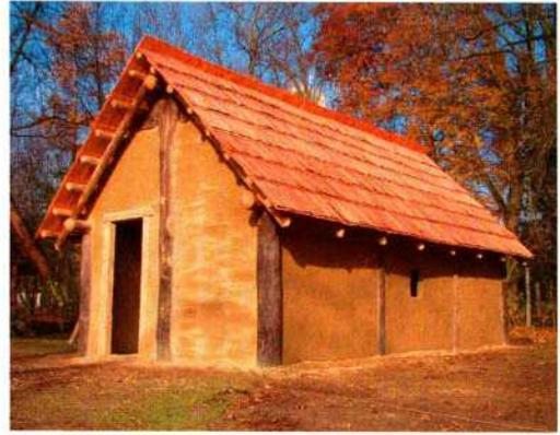
*Abb. 3: Unser fertig gestelltes Werkstättenmodell in Pfostentechnik mit Flechtwerkswänden, Lehmewurf und Lärchenschindeldach. – Our finished workshop model in post technique with wicker-work walls, loam plaster and larch shingle roof.*
