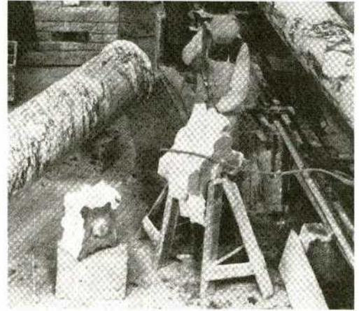
Abb. 9: Neuzeitliche Kapitell-Fabrikation in einer Werkstatt in Carrara. Um die Kapitelle symmetrisch abzarbeiten, werden diese, mit Wellen versehen und auf zwei Böcken gelagert, bearbeitet. – *Modern capital from a workshop in Carrara. These capitals were equipped with mechanical waves and were mounted on two trestles in order to be processed symmetrically.*
