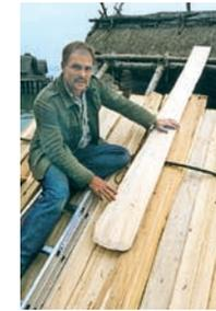
Cette maison sert aussi pour des expériences scientifiques. Sa construction, entièrement faite de bois, se distingue de la plupart des autres maisons du lac de Constance, qui ont été construites avec des poteaux en bois, de boue et d'argile et complétée par un toit de chaume. La reconstruction de 1998 est le résultat de la coopération internationale avec les archéologues du canton Turgovie, en Suisse.
