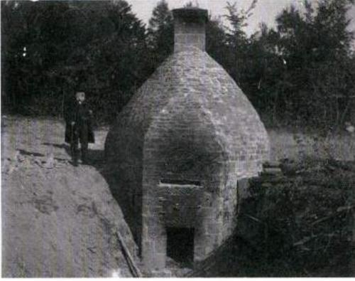
Abb. 13: Rekonstruierter Backofen mit gemauerter Kuppel 1904. – Reconstructed bread oven with stone dome in 1904.
