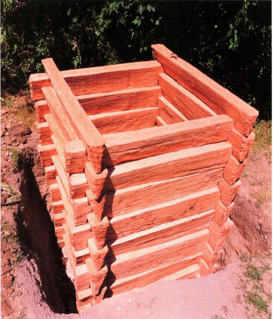
*Abb. 11: Der Brunnenkasten wird in der Baugrube errichtet. – The well's box-frame is erected in the construction pit.*
