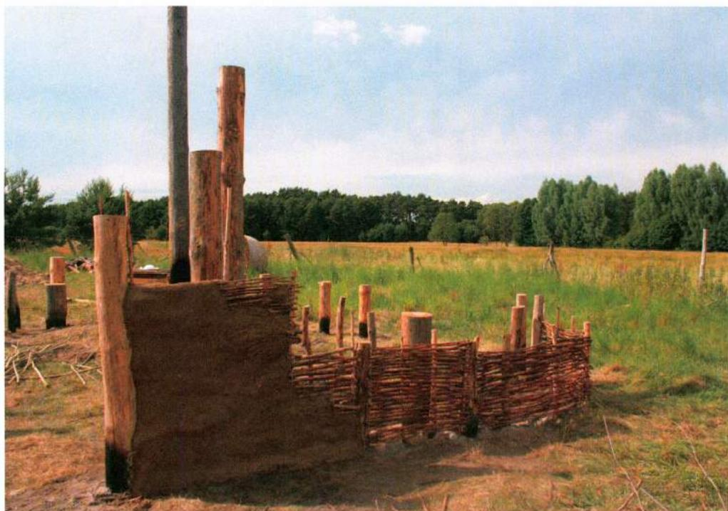
Abb. 4: Teil der rekonstruierten Flechtwerkwände mit Lehmputz „im Arbeitsprozess“. – Part of the reconstructed wattle and daub wall “in working progress”.
