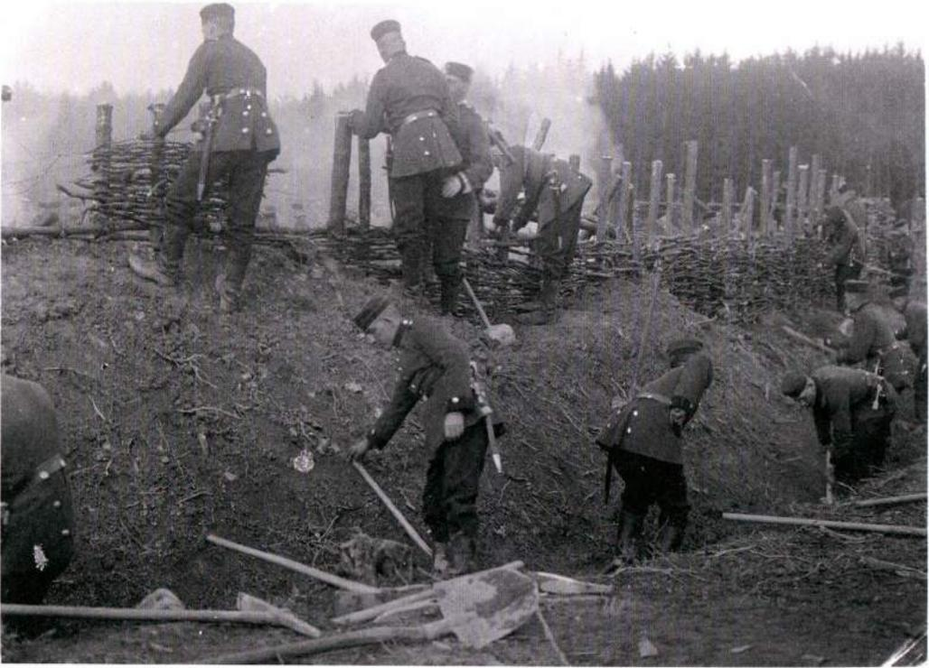
Abb. 7: Preußische Pioniere beim Bau römischer Befestigungen 1913. – Prussian sappers building Roman fortifications in 1913.
