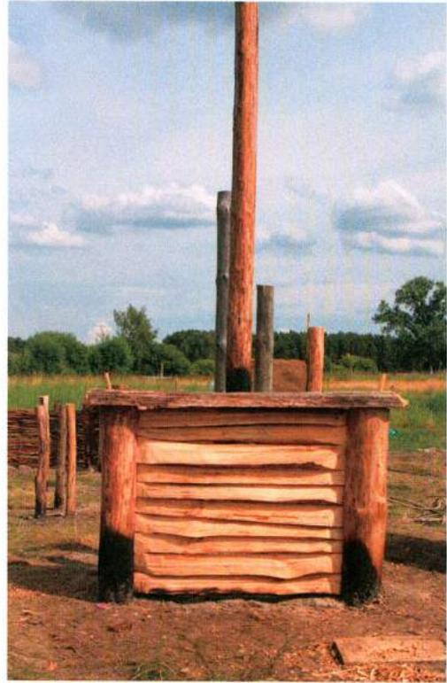
Abb. 5: Fertige Spaltbohlenwand mit „Klammerung“ zur Stabilisation. – Finished plank wall “cramped” for stability.
