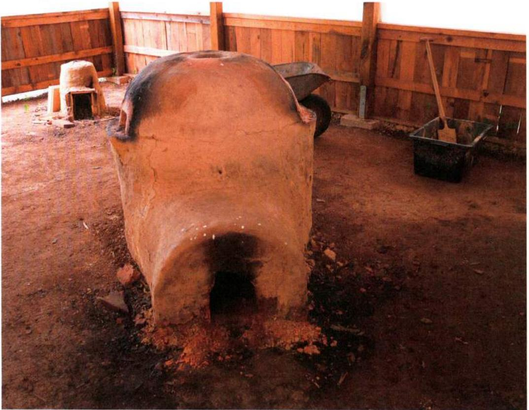
Abb. 1: Feuchtigkeitsbedingte Schäden am Ofensockel des Glas-Schmelzofens GO-Borg-1. – Damage of the glass furnace GO-Borg-1's base due to humidity.
