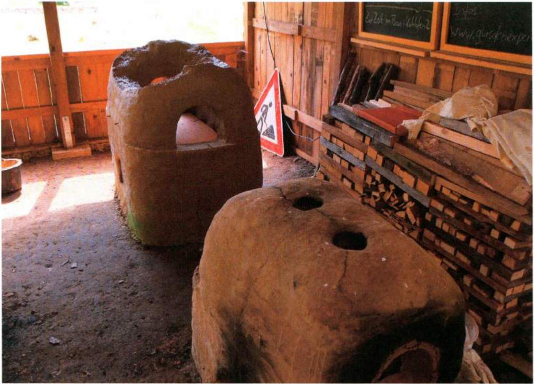
Abb. 2: Der neue und größere Kühlofen KO-Borg-2 im Bau. – Building the new and bigger Lehr KO-Borg-2.
