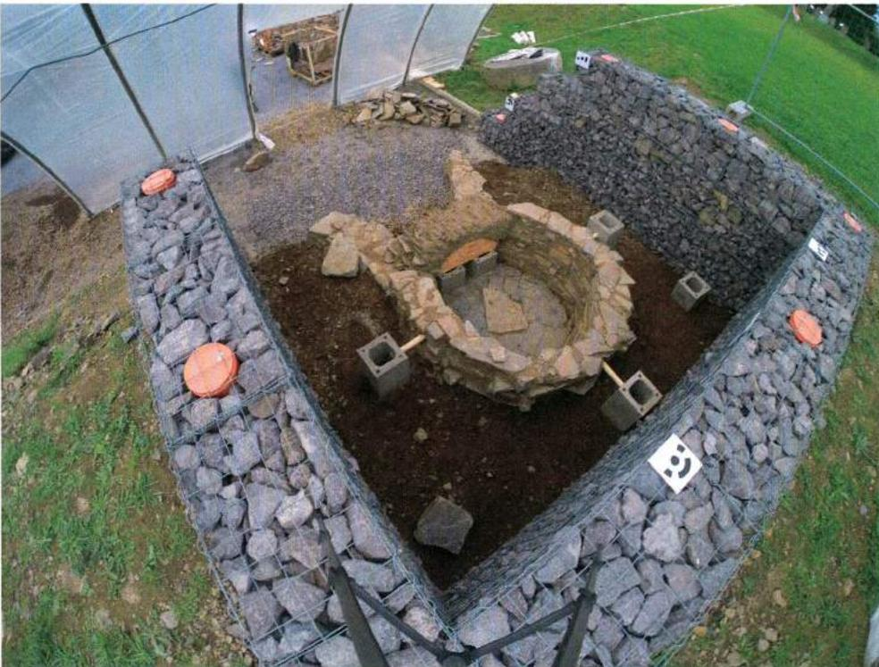
*Fig. 4: Construction of the combustion chamber and stoke hole arch. The shafts and tubes for insertion of measurement instruments are also visible around the outside of the kiln. – Bau des Feuerungsraumes und der Schüröffnung. Die Schächte und Rohre für die Messinstrumente sind auch zu erkennen.*
