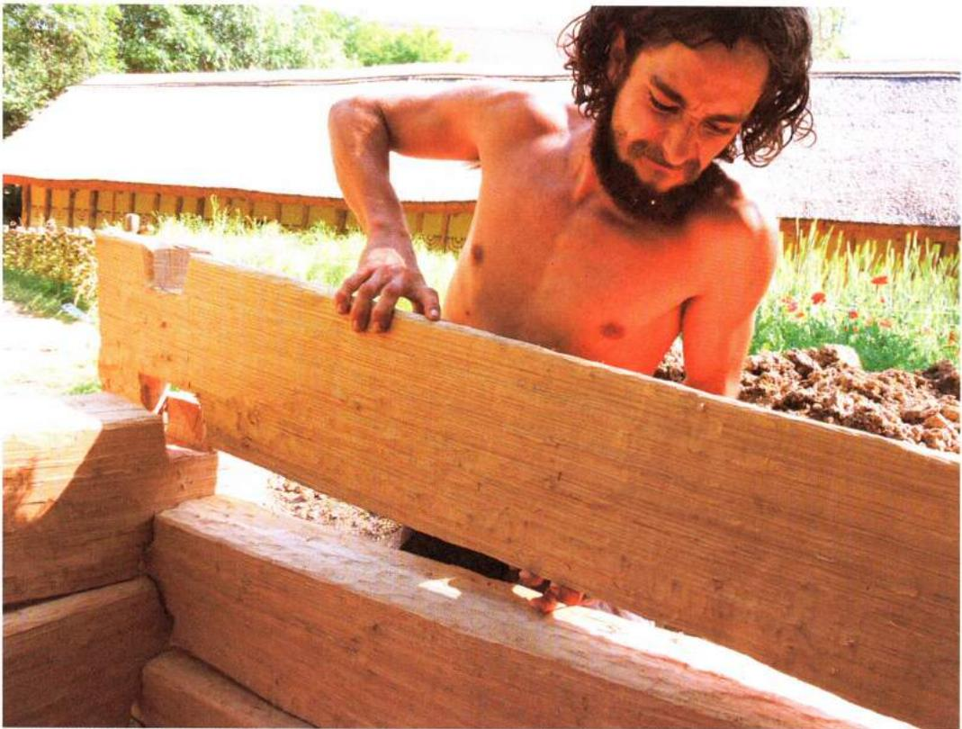
Abb. 12: Jeder Teil des Brunnenkastens war individuell angefertigt und passte nur an der richtigen Stelle. – Each element of the box-frame was produced individually and fits only at the correct position.
